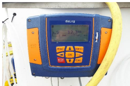
Meetpaneel om de waterstofperoxideconcentratie te monitoren (Prominent Belgium S.A., N.V)
