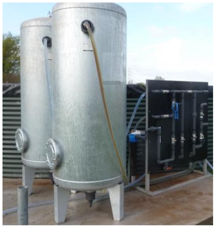
Opstelling met mogelijkheid tot terugspoelen onder druk
